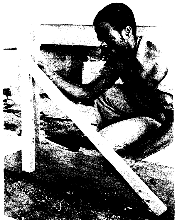
Fig.45 Afin que les montants soient d'équerre avec les longerons, vérifier avec une grande équerre de maçon
