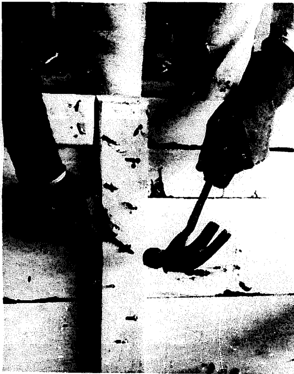
Fig.190 Retourner les clous dépassant des renforts et de la carlingue. Les meilleurs charpentiers retourneront la pointe des clous dans le bois à l'aide d'un clou de 10 cm Fig.190 The remaining nail ends are turned under
