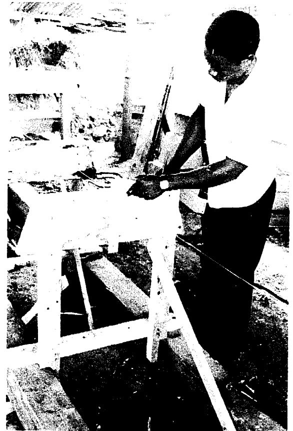
Fig.60 Le cordeau doit tomber sur la ligne d'axe des planches de montants. Prendre soin de pincer le cordeau afin de s'assurer qu'il est vraiment droit
