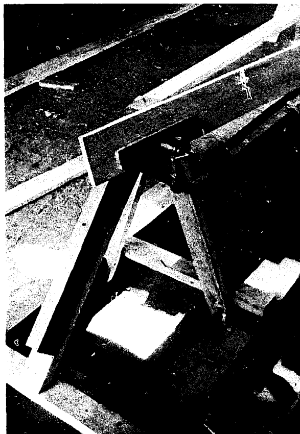
Fig.102 On le maintiendra par un serre-joint dont la vis est calée d'un bloc pour ne pas abîmer le bouchain. On pliera le bouchain jusqu'à l'autre étrave pour s'assurer de sa longueur suffisante. Si la planche est trop courte on y fera un joint. (Voir détail au chapitre joint.) On fera de même pour l'autre bouchain. Appliquer le produit d'étanchéité sur les deux côtés de l'étrave. Reposer le bouchain en prenant soin que le doigt du serre-joint appuie contre le porte-étrave et l'arête de l'étrave
