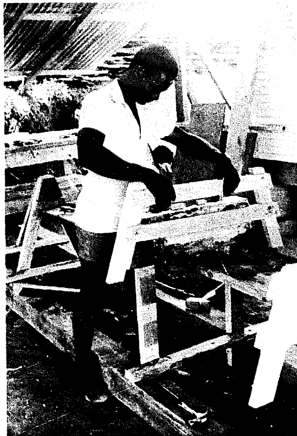
Fig.77 Installer les membrures à cheval sur les planches de montants de façon à ce que les traverses touchent la face des planches et que les côtés des membrures embarquent sur les côtés des planches. Les traverses doivent donner vers le centre de la pirogue. Vérifier que la traverse du bas de la membrure soit partout à l'égalité du dessus de la planche de montant
