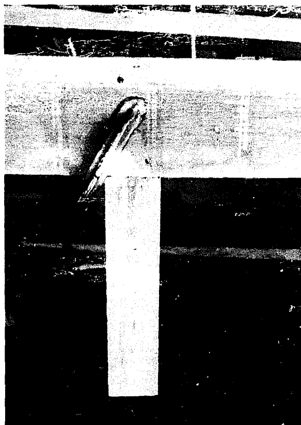
Fig.126 Il est préférable que la vis de la presse soit à l'intérieur de la pirogue et le doigt de la presse centré à l'extérieur du bouchain pour pouvoir clouer de chaque côté Fig.126 The clamp screw should be on the inside of the canoe to ease nailing, the clamp finger at the centre of the plank to permit nailing on each side of it
