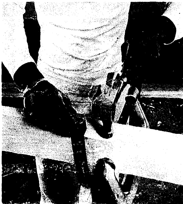
Fig.124 Aligner le centre des renforts sur ces marques et tenir par une presse. Ajuster le renfort à 2 ou 3 mm plus bas que le bouchain Fig.124 Match centre of stiffeners with these marks and hold with a C-clamp. Adjust stiffeners 1/2" lower than the chine
