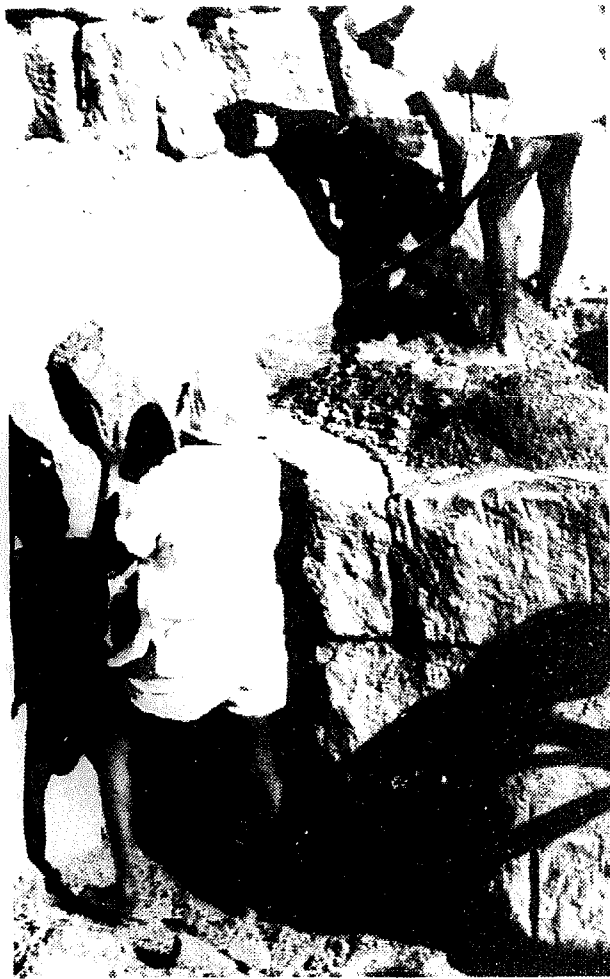
a. Digging clay
