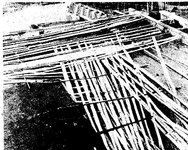
La fotografía muestra parte del refuerzo de bambú de las vigas B-1 y B-9 del Edificio para Periodistas. Nótese que la hilera superior del refuerzo inferior de la viga B-1, se ha doblado hacia arriba en la parte correspondiente al cantilever de la viga B-9.
