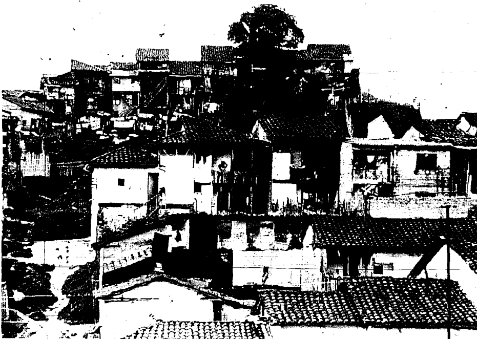
La fotografía muestra diversos tipos de techos con cubierta de teja de barro, que comúnmente se construyen en bambú.
