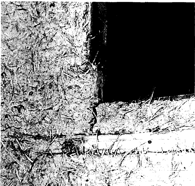
DETALLE 3.1.3.2-A MURO DE BAHAREQUE
