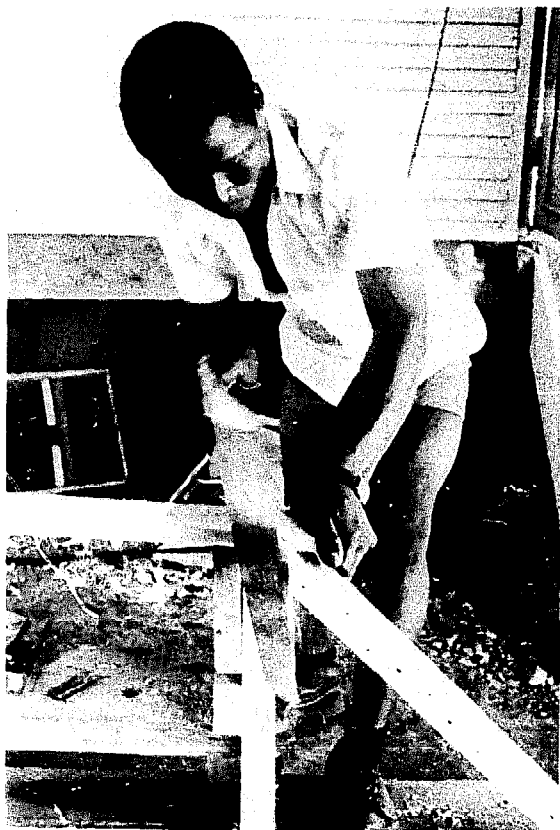
Fig.91 On scie les bouts dépassant des porte-étraves
