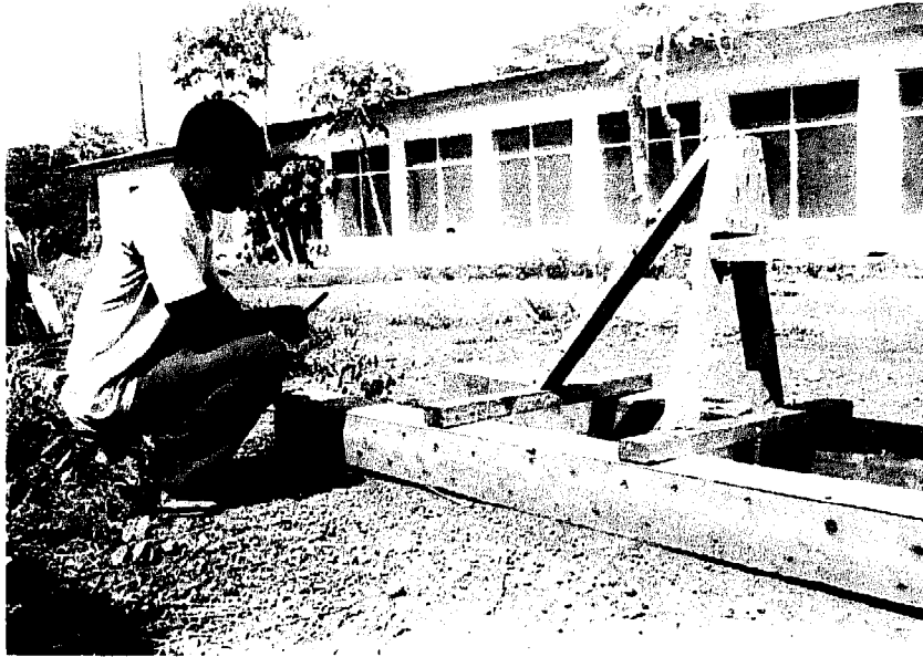
Fig.40 On vérifiera la ligne droite horizontale en tirant un cordeau à l'arête des longerons
