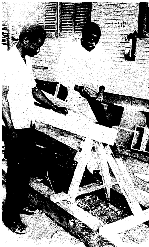
Fig.112 Couper le bout de la deuxième planche de bouchain Fig.112 Cut the end off the second chine plank
