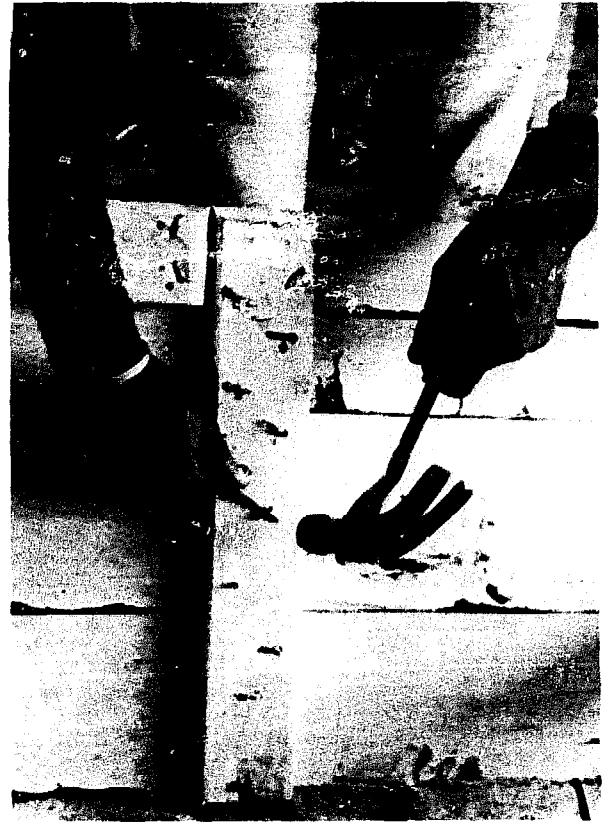
Fig.130 Le charpentier chevronné se servira d'une grosse pointe comme appui sur le bout du clou pour le retourner dans le renfort Fig.130 The experienced carpenter bends the nails over a bigger nail
