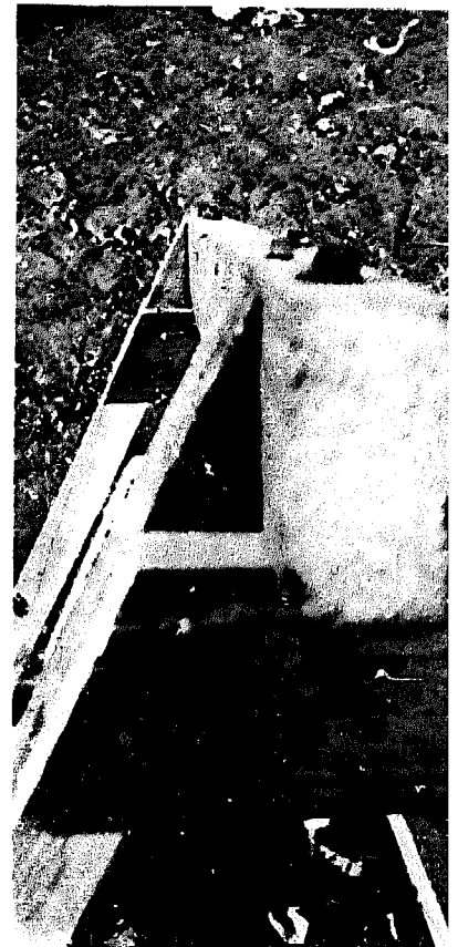
Fig.30 La tige filetée traverse taquets et la traverse du ha Fig.30 The threaded rod crosses upper brace and upper crossbar
