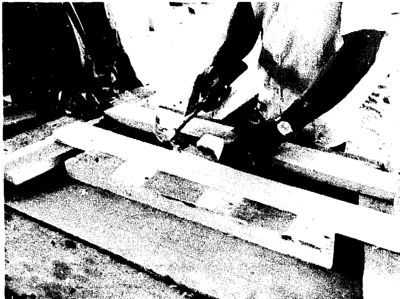
Fig.72 Coincer les deux traverses par un bloc et un coin. Taper doucement sur les bouts de côtés de membrures pour s'assurer qu'ils buttent contre le gabarit. Avec le gabarit troué de traverses marquer les trous de vis sur chaque traverse
