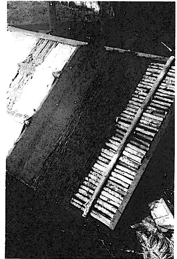
Abb. 6.18 Pajón, auf der Oberfläche dünn ausgebreitet und in die weiche Erd-Kalk-Mischung gedrückt.
