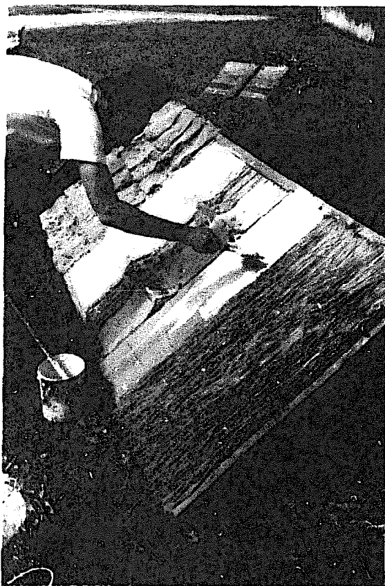
Abb. 6.22 Kalkanstrich auf der Erd-Kalk-Oberfläche. Fig. 6.22 Application of limewash on soil-lime surface.
