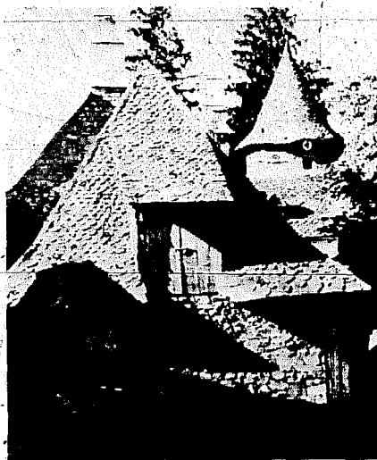
Ci-dessus: petite porte donnant accès au grenier d'une maison de Corrèze.
