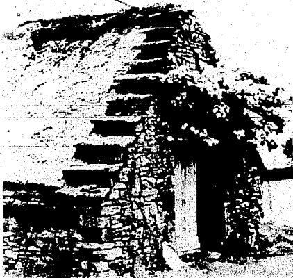
Ci-dessus: en Bresse, galerie extérieure "au sol," caractéristique de cette région. Ci-dessous: rampants à "pas de moineaux" constituant de véritables marches d'escalier, couramment utilisées pour l'entretien du toit (Bigorre).
