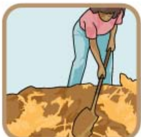
Mix a mud-straw mortar.
