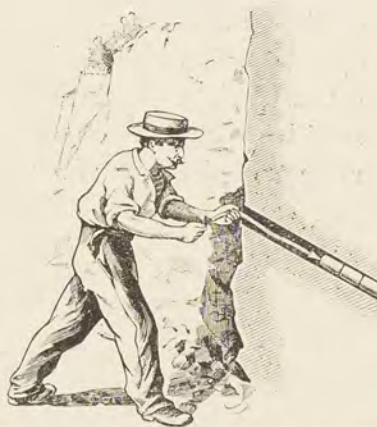
FIG. 156. — Pose de la cartouche qui porte le détonateur et la mèche.
