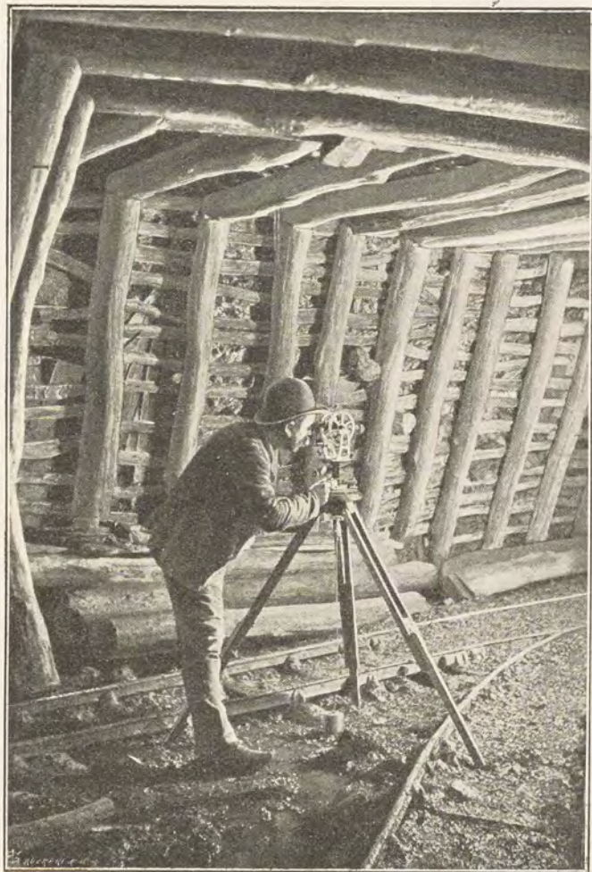
FIG. 138. — Levé de plan au théodolite dans une galerie de mine.
