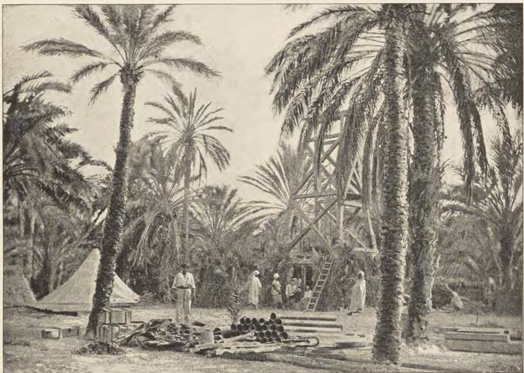
FIG. 39. — Installation d'un atelier de sondage dans une oasis.
