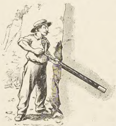
FIG. 155. — Ouvrier plaçant une cartouche dans le trou de mine.
