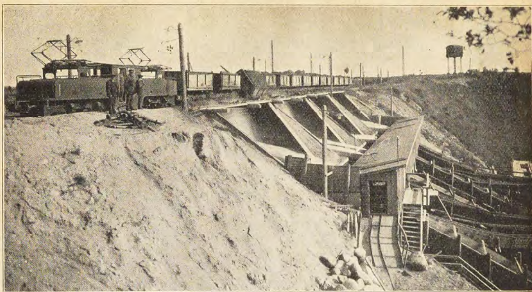
Abb. 21. Die Blaue Erde wird aus der Förderbahn in die Bernsteinwäsche gestürzt, um dort aufbereitet zu werden. (Nach einer Photographie im Besitze der Bernsteinwerke Königsberg i. Pr.)
