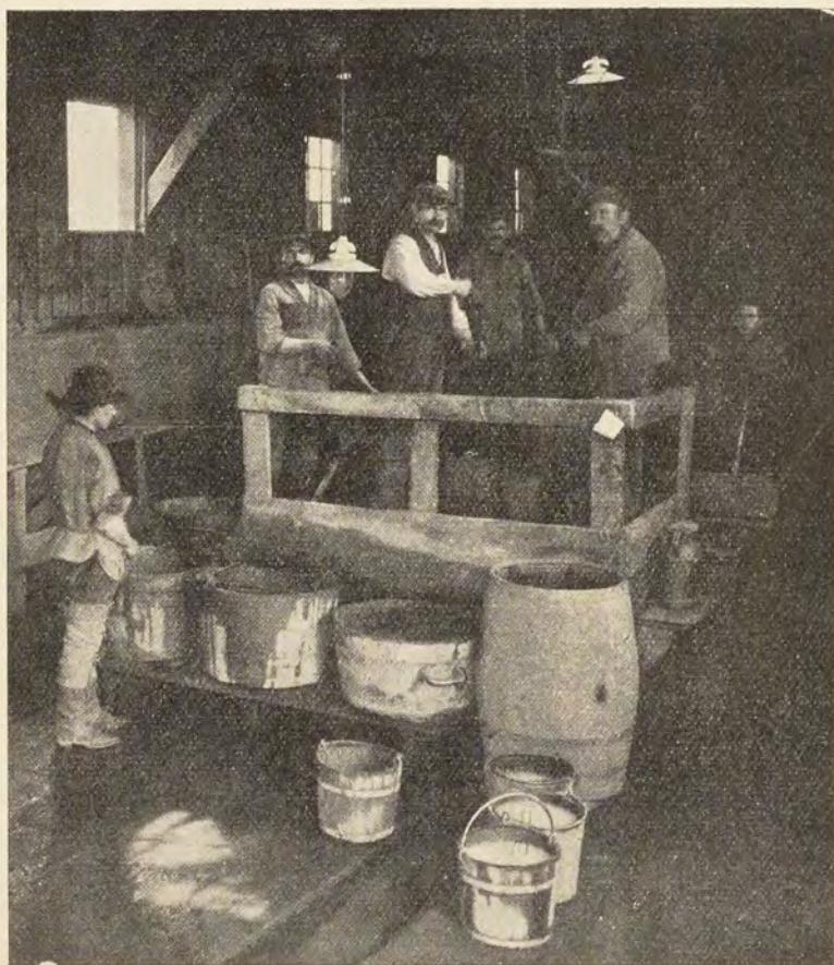
Abb. 22. Der ausgewaschene Bernstein wird in mit schlammigem Wasser gefüllten Bottichen von Verunreinigungen getrennt. (Nach einer Photographie im Besitze der Bernsteinwerke Königsberg i. Pr.)
