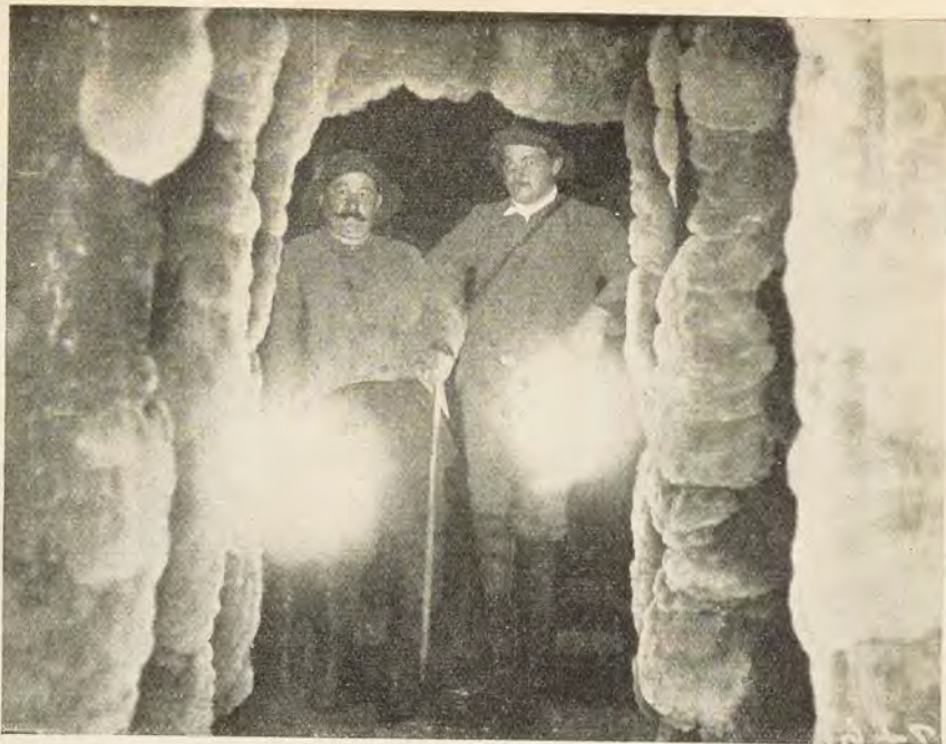
Abb. 16. Eine durch Zimmerung vollständig ausgekleidete Strecke in den viele Kilometer langen Stollen der Grube „Anna“. Die Zimmerung ist von dicken überhängigen schneeweißen Schwammbildungen bedeckt, welche einen enormen Holzbedarf bedingten. (Nach einer Photographie im Besitze der Bernsteinammlung der Albertus-Universität zu Königsberg i. Pr.)
