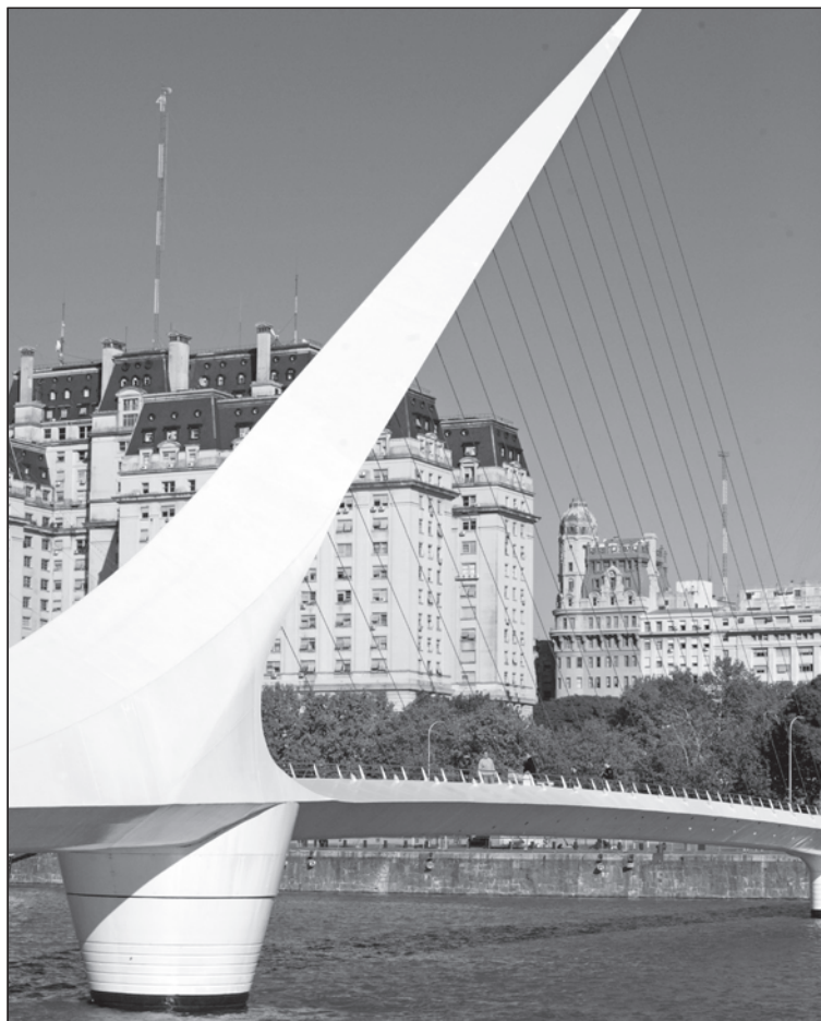
▲ Puente de la Mujer, Puerto Madero
