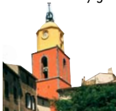
Eglise de St-Tropez tower
