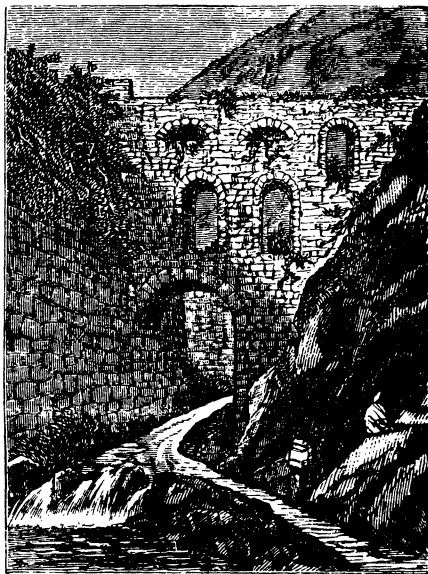
AQUEDUCT OVER THE RODADERO.
