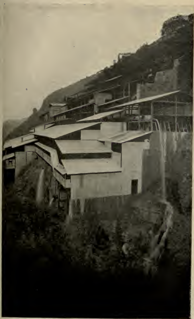
Mills and Cyanide Works, Passagem Gold Mine, Minas.
