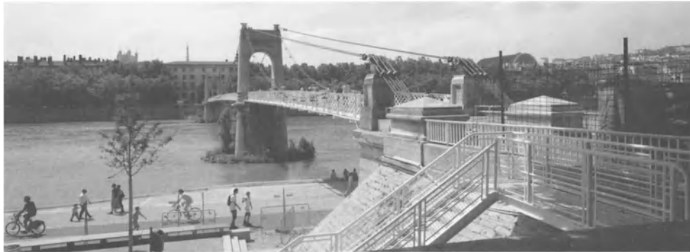
Passerelle du Collège, 1844, main span 109 m, total 198 m
