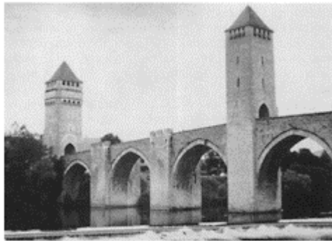
Cahors (Lot), Pont Valentré.
