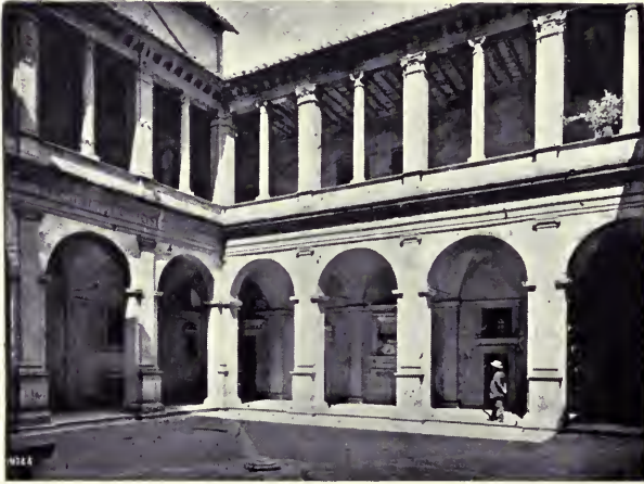
Fig. 192.—Rome, Sta. Maria della Pace, Cloister.
