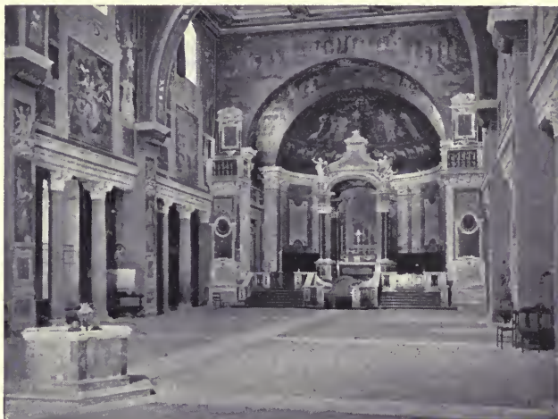
Fig. 201.—Rome, Sta. Prassede.
