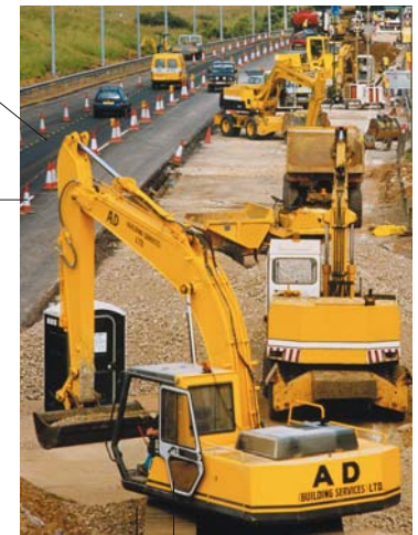
odnowa nawierzchni resurfacing
