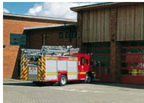
posterunek straży pożarnej fire station
