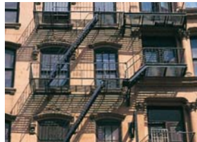
la scala di sicurezza fire escape
