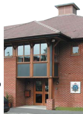
la stazione di polizia police station
