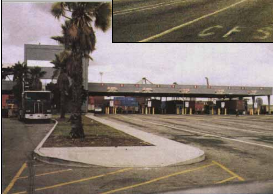
Gate to Long Beach Container Terminal (Berths F8 - F10)
