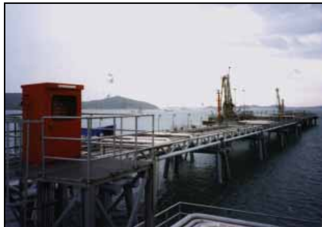
Outboard End of the LNG Pier
