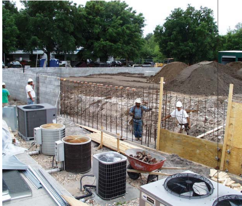
Pouring the Foundation
