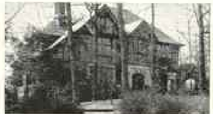
S. H. Tomlinson residence, High Point, N. C.
