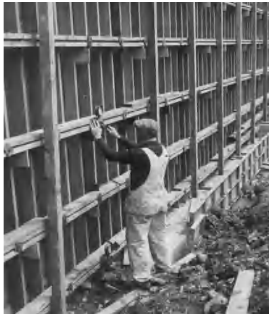
Fig. 2. Concrete form. ( Superior Concrete Accesories )
